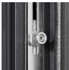
Serrure automatique 5 points à galets réglables sur portes à un seul vantail (à relevage sur portes d'entrée 2 vantaux)
